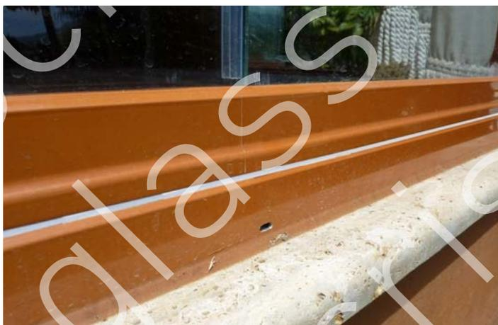
Uscita di acqua che si può accumulare nel sistema
