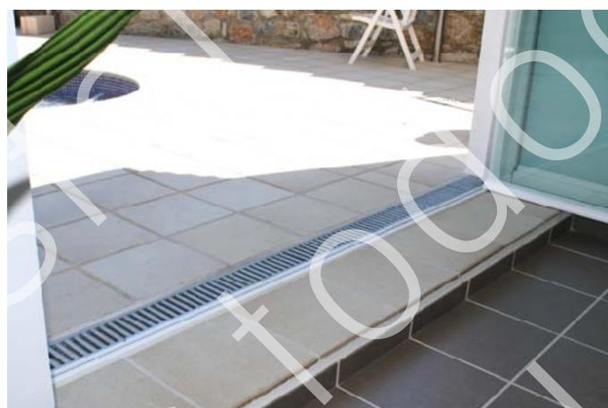
Il sistema si può incassare completamente e creare uno scarico per l'acqua prodotta per la condensazione nella parte inferiore del vetro
